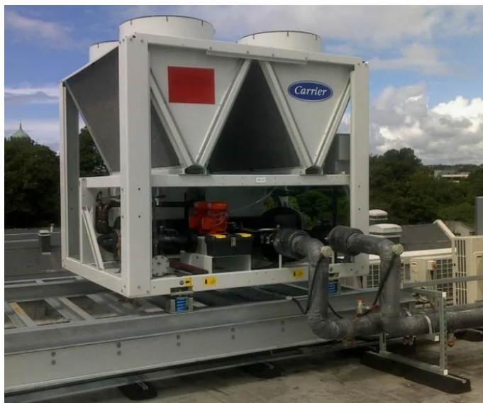
Рисунок 6 – Монтаж оборудования на виброопоры и тепло(звук) изоляцией трубопроводов
