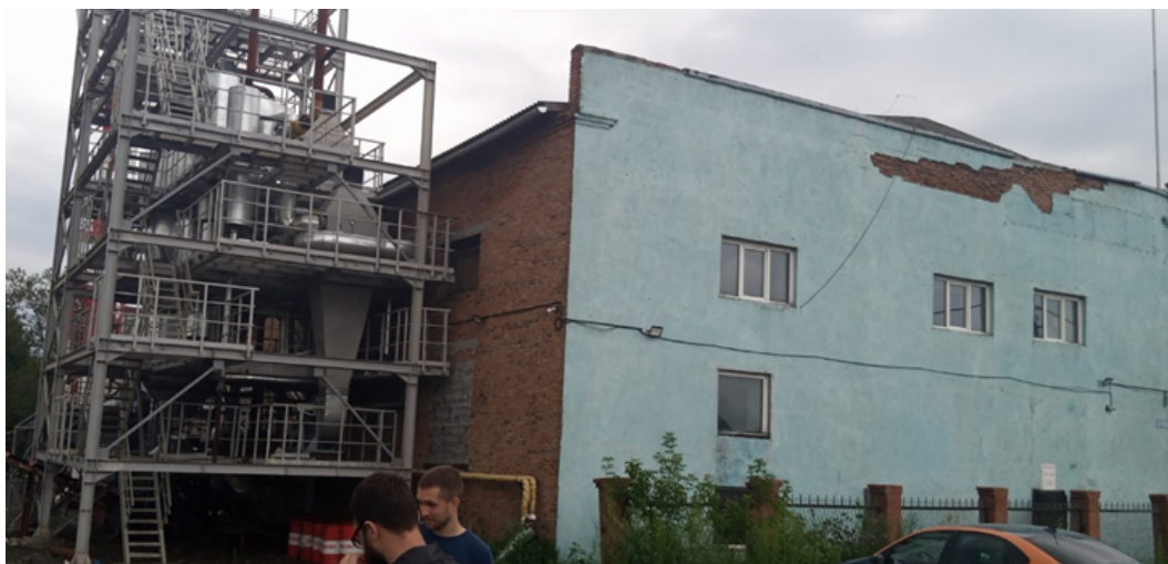
Рис. 1. Промышленный объект, на котором проводилось исследование
