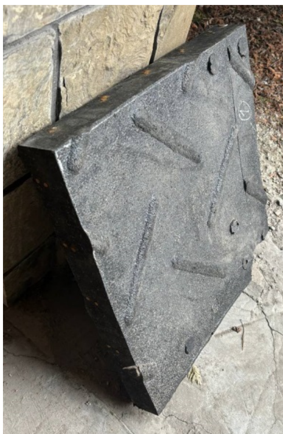
Рисунок 6 – Дорожная плита НЦК
