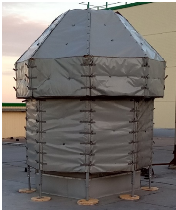
Рисунок 5 – Кожух для снижения шума вытяжной системы
